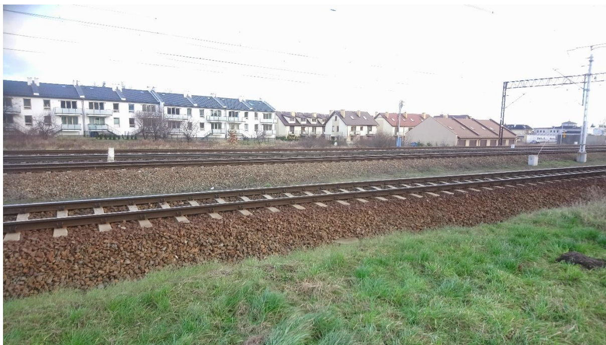
Fotografia 1 Analizowana linia kolejowa nr 250 w Rumii
